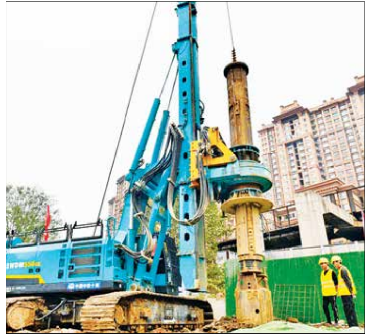
郑济高铁引入济南枢纽工程首墩首桩开钻
